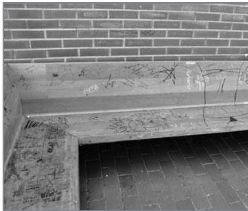
Tidligere har skriblerier på veggen og hærverk på stasjonsbygningen i Moelv vært et utendørsproblem. Nå er benkene i stasjonsbygningen tildekt av stygge svarte tusjstrekker. (Foto: Brede Nordhagen)
